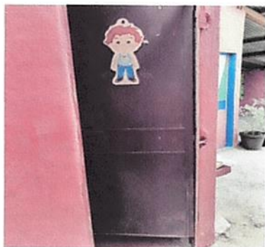
Foto 3: Reparación de puertas de baño.
