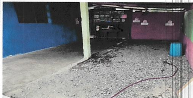
Foto 4: Fundición de concreto de 10 cms.
