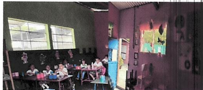
Foto 2: Instalación de ventanas de PVC y sedaso.
