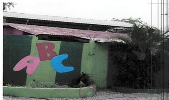
Foto 6: Sustitución de lámina troquelada calibre 26.
