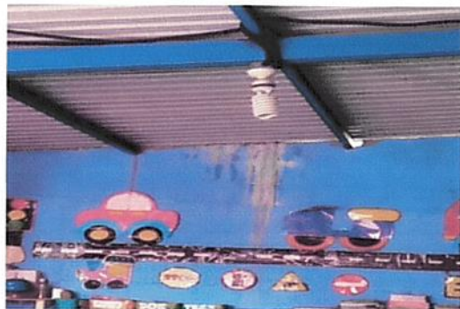
Foto1: Reparación de filtración de paredes existentes.
